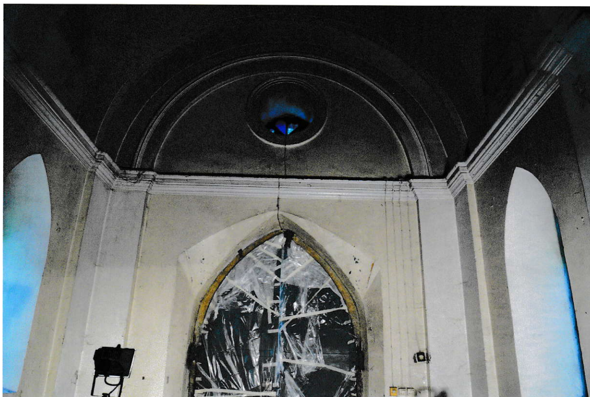
Fot. 2. Fragment wnętrza kaplicy, ściana wschodnia.
